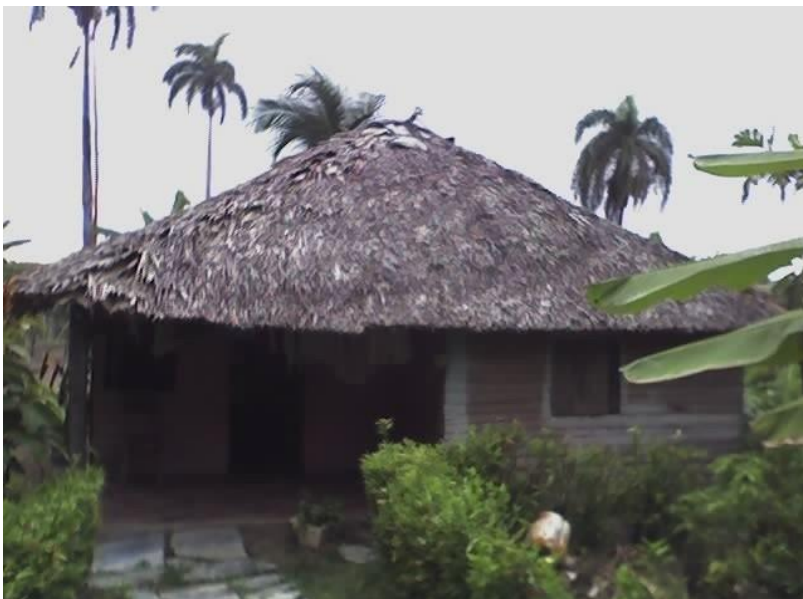
Fig. Casa típica Cañete.
